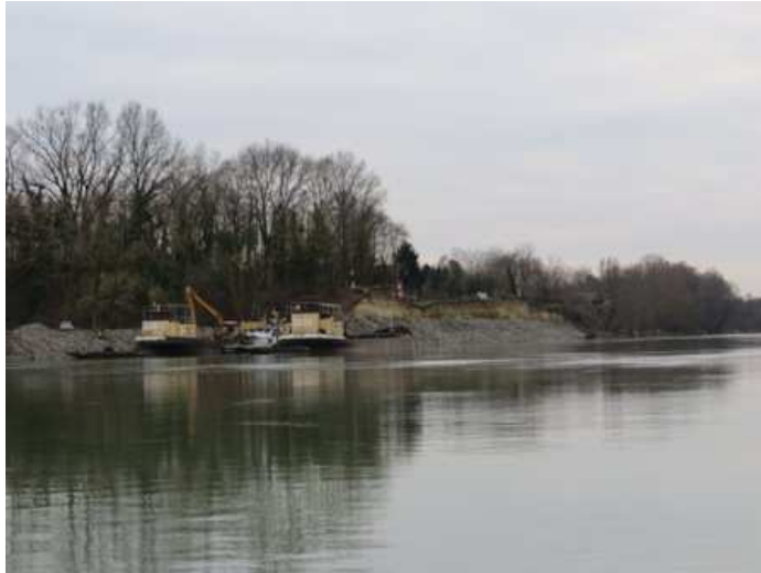
Slika 1. Izgradnja obaloutvrde na 65 rkm rijeke Drave u tijeku. 22. siječanj 2014.
