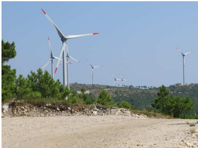
Slika 4. VE Ponikve na Pelješcu. Pristupne i servisne prometnice su znatno šire od 6,5 m u kruni zbog omogućavanja prolaska teške mehanizacije tijekom njihove izgradnje (Foto: ©Mikuska T. /Hrvatsko društvo za zaštitu ptica i prirode)
